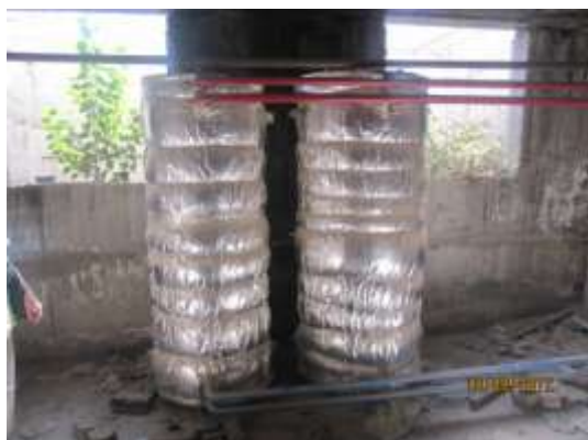
Тепломодернизация теплового пункта
