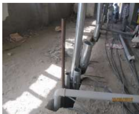
Система воздуховодов вентиляции
