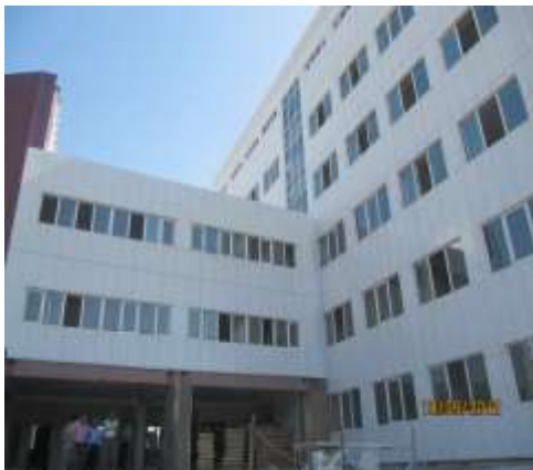
Общий вид здания
