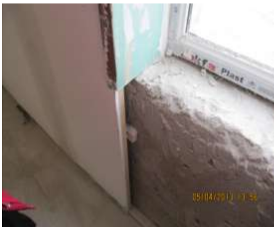
Установка гипсокартона
