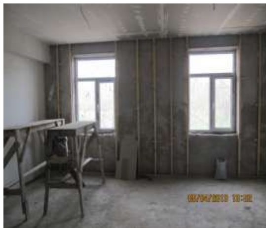
Подготовка стен для теплоизоляции
