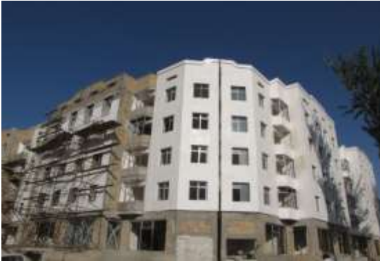
Общий вид жилого дома
