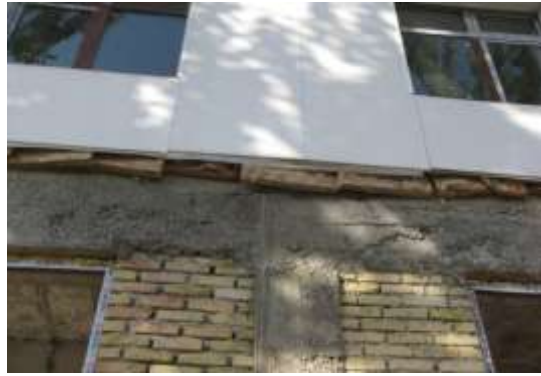
Фрагмент вентилируемого фасада
