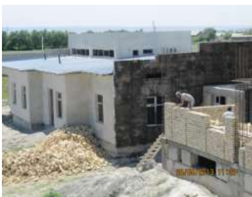
Общий вид здания
