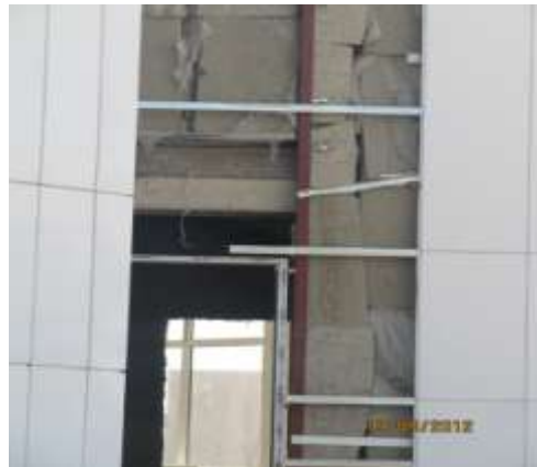
Фрагмент вентилируемого фасада
