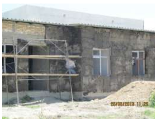
Теплоизоляция фасада
