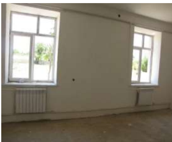
Монтаж радиаторов и труб отопления
