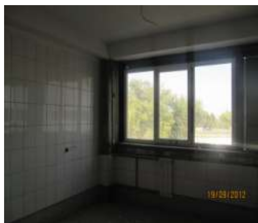
Установка оконных блоков
