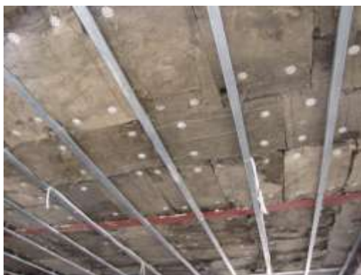
Теплоизоляция перекрытия
