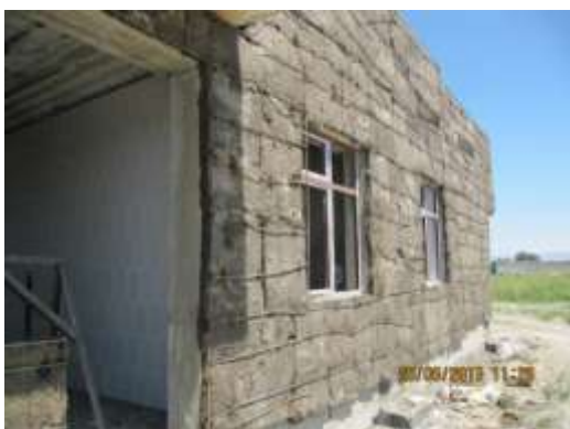
Установка армирующей сетки
